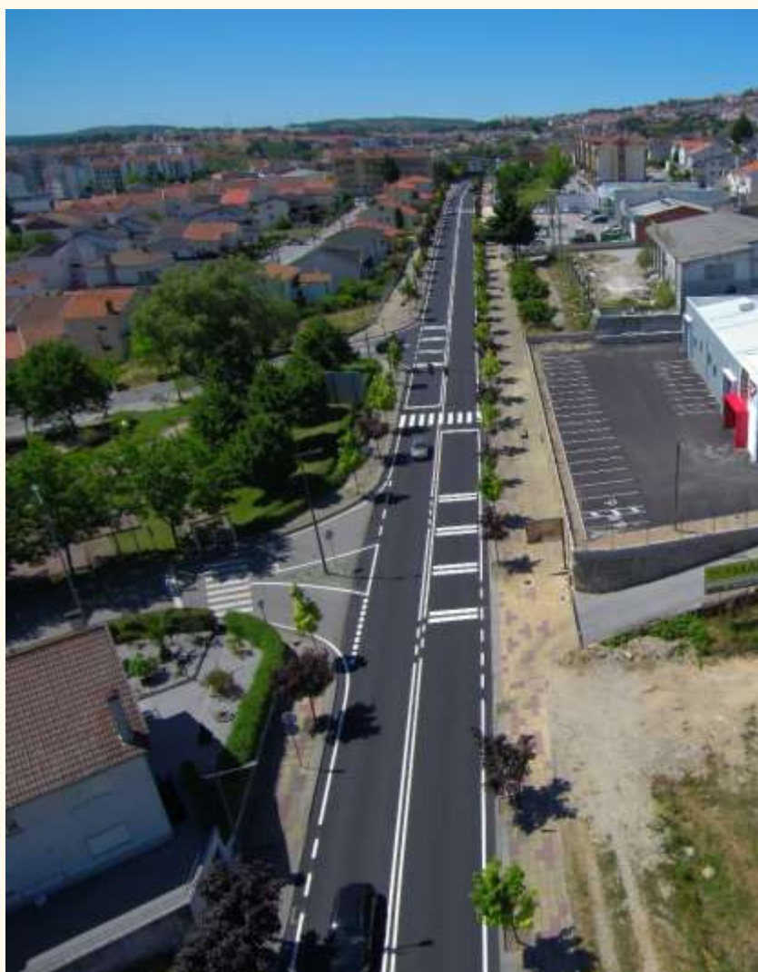
19134 – Reparações de anomalias na Av. 25 de Abril e envolvente - Guarda
