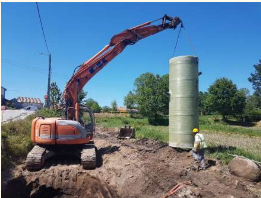
18192 -Construção da ETAR do Touro – Vila Nova de Paiva
