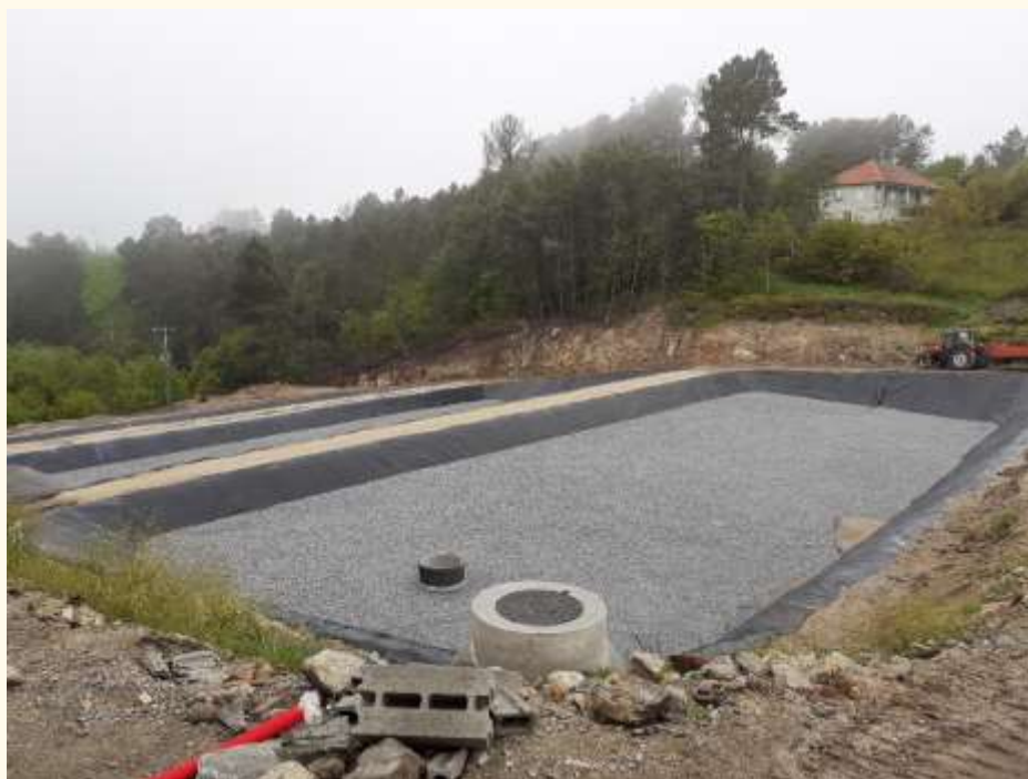
18193 – Construção da ETAR de Vila Cova à Coelheira – Vila Nova de Paiva
