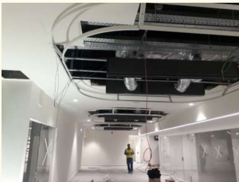
20042 - Instalação do balcão Único do IRNIP - Marinha Grande
