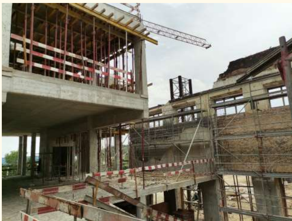
18227 – Requalificação central Edifício com Polivalência (Porto de Mós)
