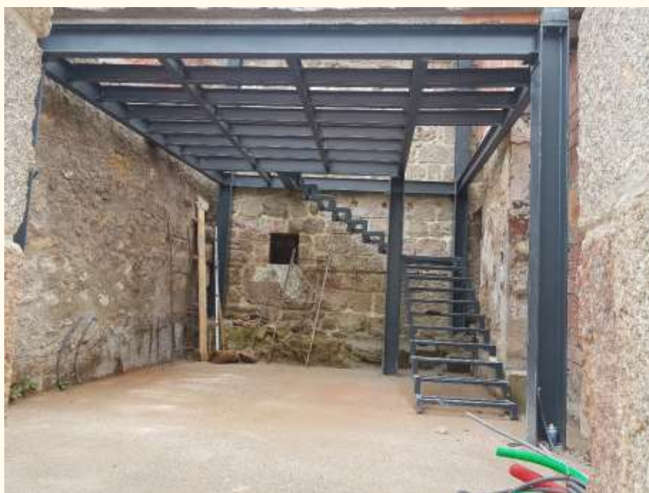
17214 – Reabilitação dos Edifícios Municipais na Zona do Torreão - Guarda
