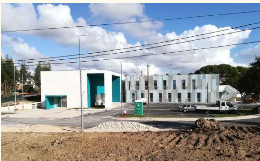
18094 - Construção da Unidade de Saúde de Santo Onofre - Caldas da Rainha
