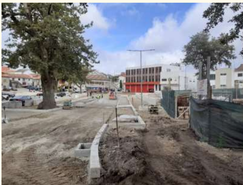
19134 - Reabilitação urbana do Campo da Restauração e áreas adjacentes - Vila Nova de Paiva
