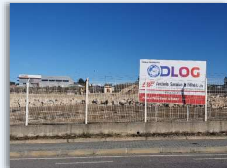
EXECUÇÃO DE ARMAZÉM NA PLIE DA GUARDA (D-LOG)
