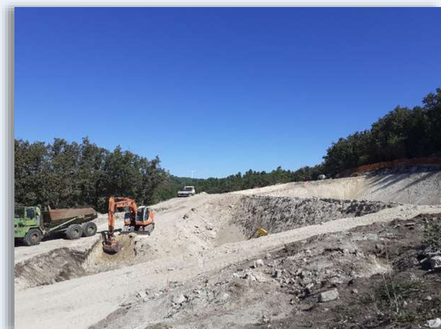
CONSTRUÇÃO DA ETAR DE TOURO
