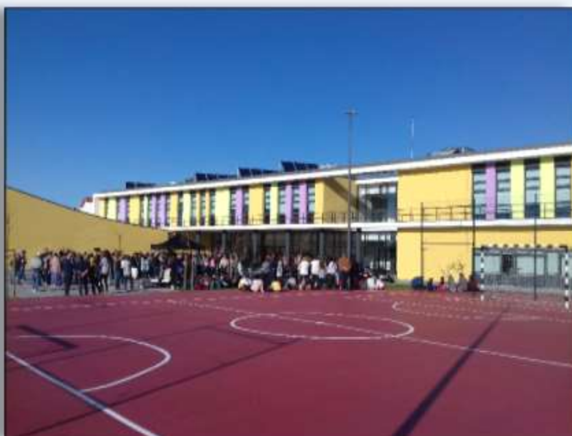
CONSTRUÇÃO DO CENTRO ESCOLAR DE ATOUGUIA DA BALEIA
